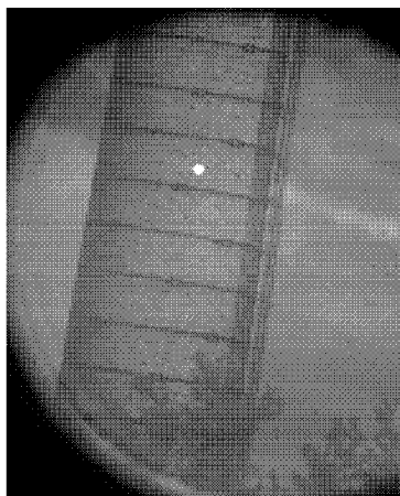
Рисунок 1 а. Лазерное пятно на кирпичной трубе, расстояние 578 м
